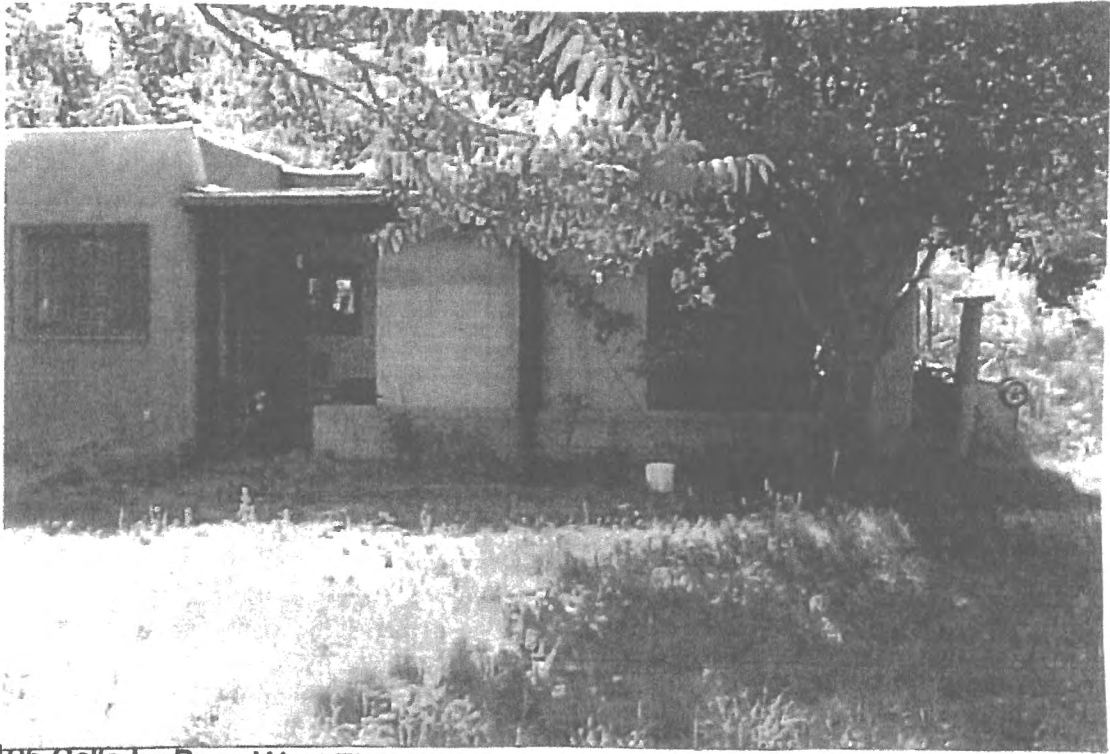
105 Calle La Pena West Elevation
