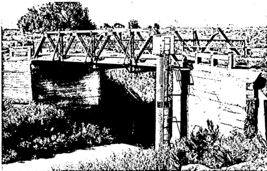
Fig. 43. Chicorico Creek Bridge (No. 7743)
