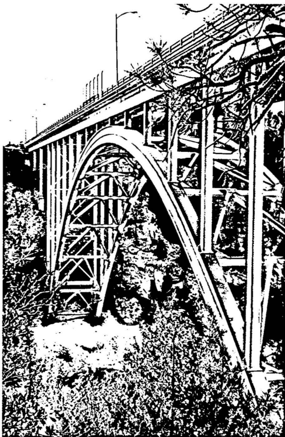
Fig. 48. Los Alamos Canyon Bridge (No. 7622)
