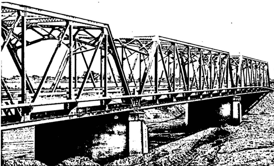
Fig. 33. Rio Felix Bridge (No. 357)
