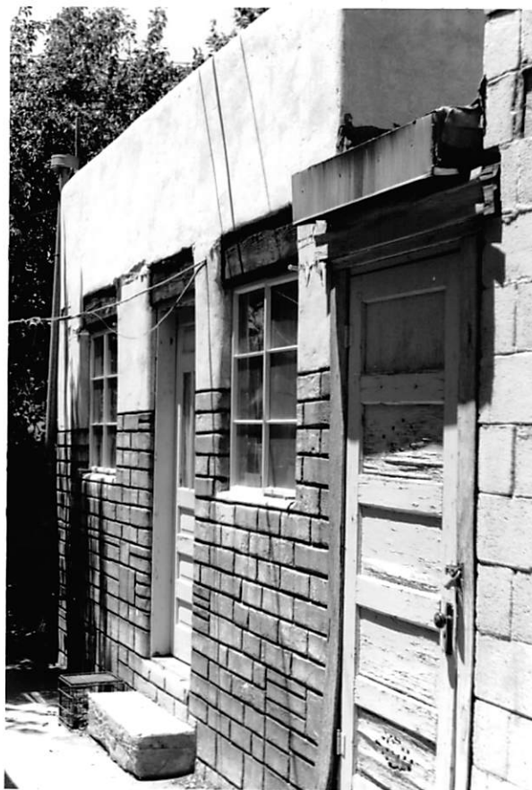
#14 S. Elevation & Shed
